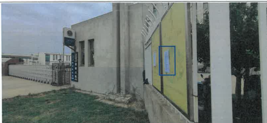
滨海新区公安局(南港派出所)
