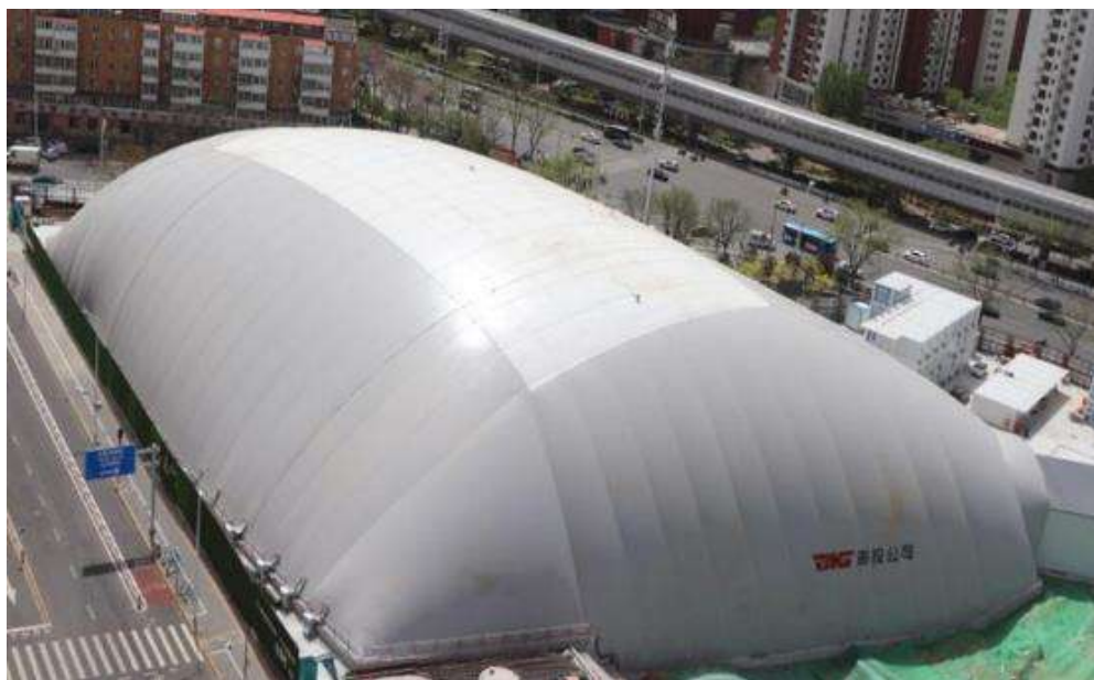
图 4-1 基坑气膜施工现场示例图
