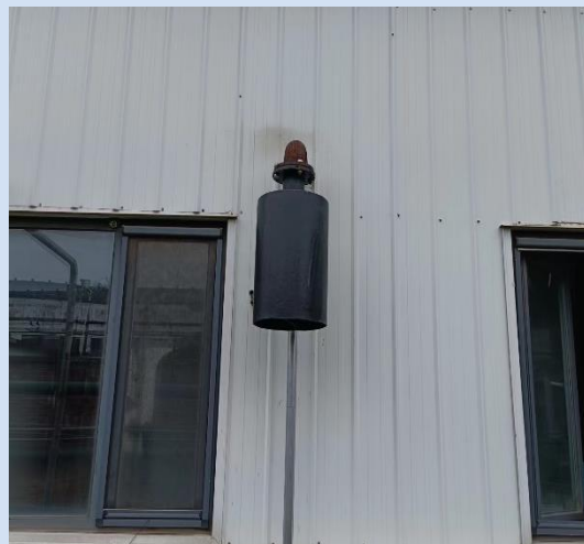
机房设备安装消声器
