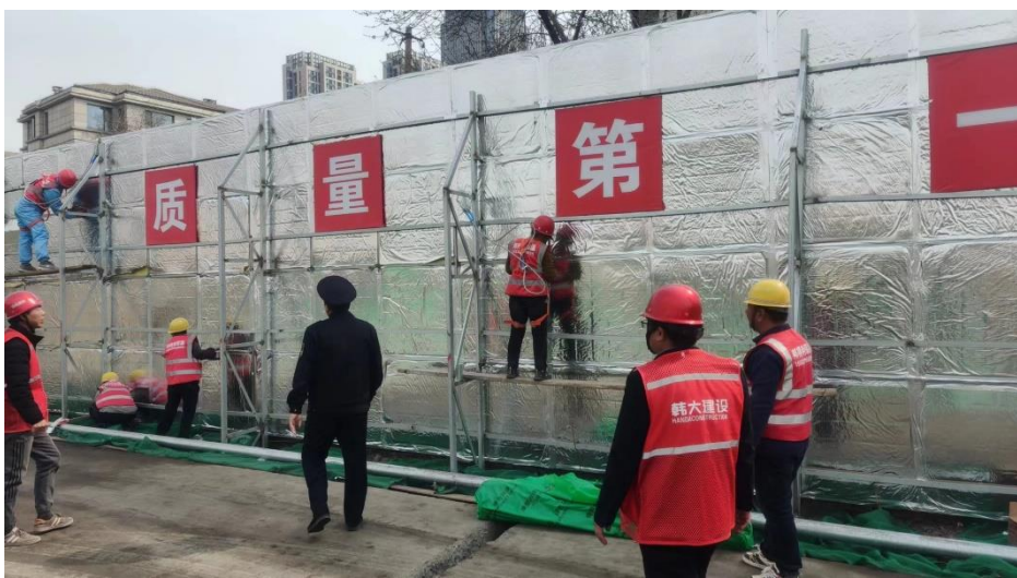
图 3-1 施工单位安装隔声屏障
